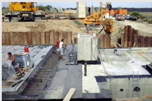
Bau des Pumpspeicherbeckens
