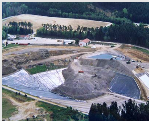
Deponie Eberstetten II (Sommer 2004)
