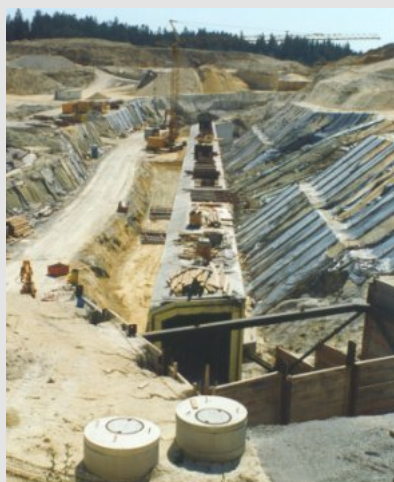
Stollen in der Bauphase
