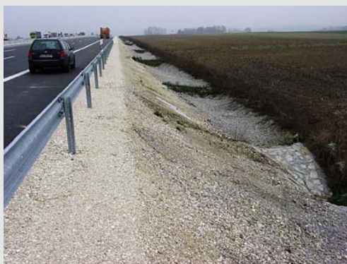
Versickerungsrigolen unmittelbar nach Bau
