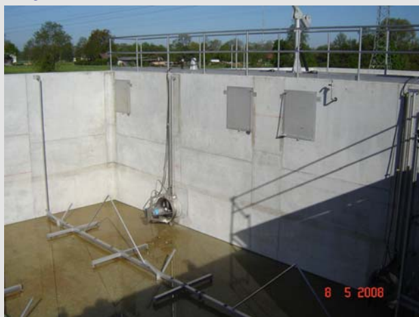
Kläranlage Langenpreising in Bau, neues SU-Becken mit Belüftungseinrichtung
