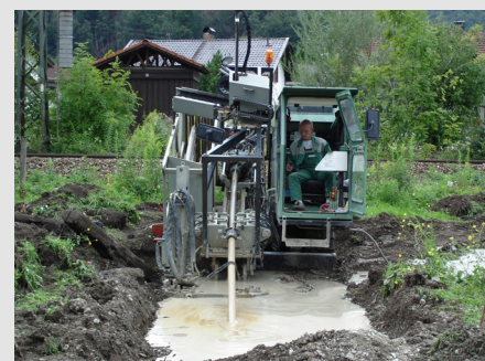
Spülbohrung unter der Loisach
