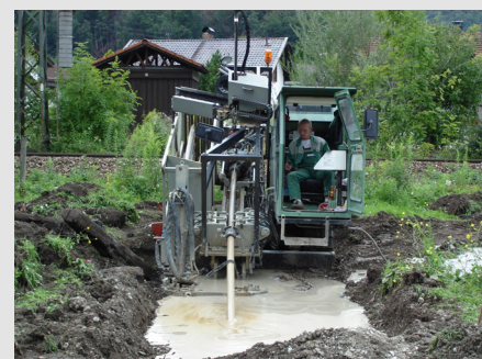
Spülbohrung unter der Loisach
